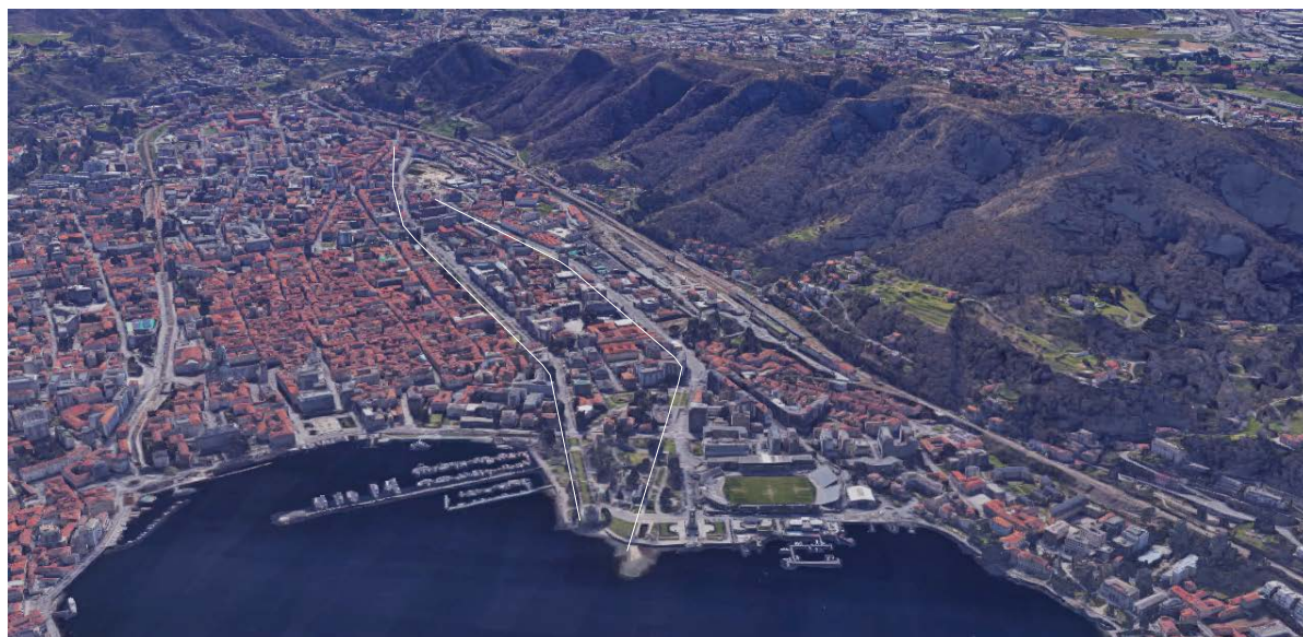
Il radicamento nella struttura urbana dei due assi di Via Marconi e del tratto terminale del Cosia
