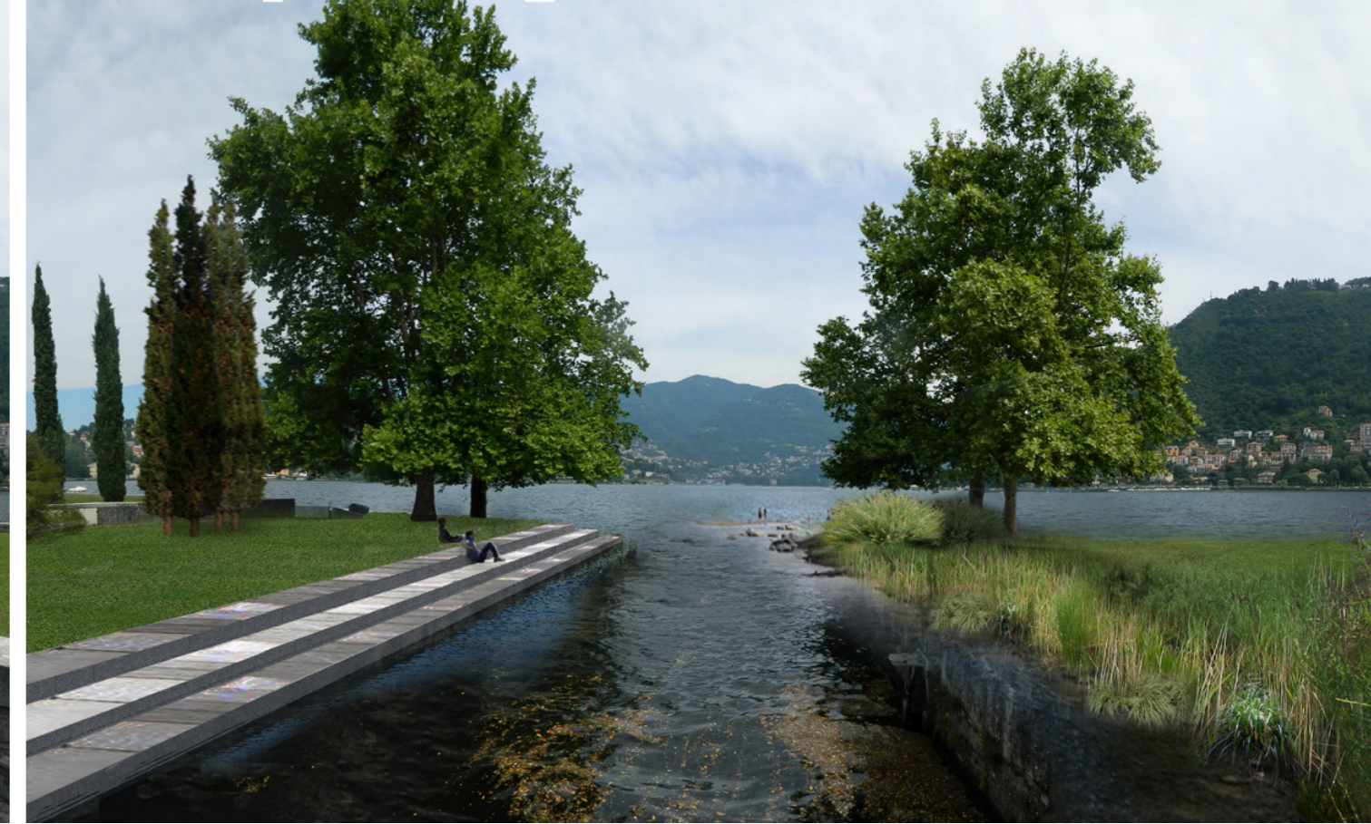
Foce del Cosia: riapertura completa del tratto terminale; rinaturalizzazione della riva destra; accessibilità all'acqua sulla riva sinistra con sistema di gradoni in grandi blocchi squadrati che segnano i diversi livelli dell'acqua nel contesto del Monumento ai Caduti
